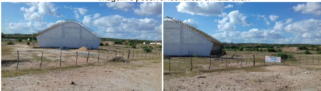
Figura 04 - quadra de esporte sendo construída na vazante do leito do rio. Ao fundo da imagem é possível identificar a mata ciliar.
