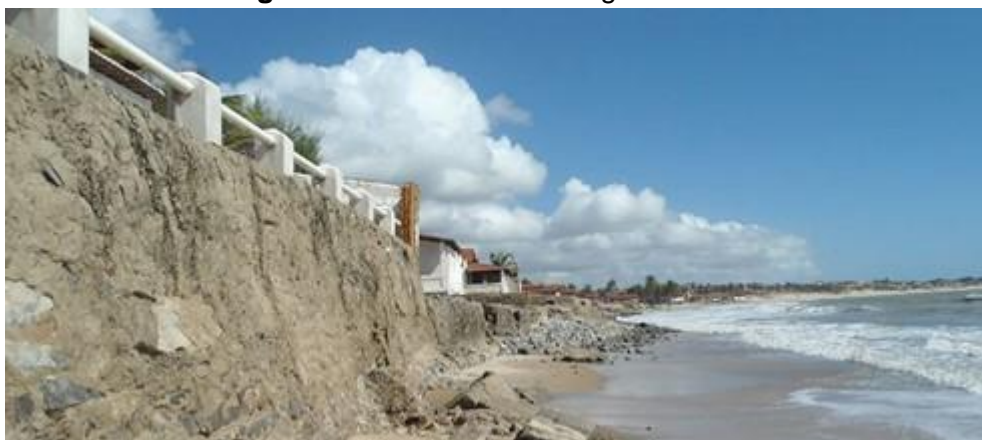
Imagem 1 – Mostrando o estágio da erosão.
