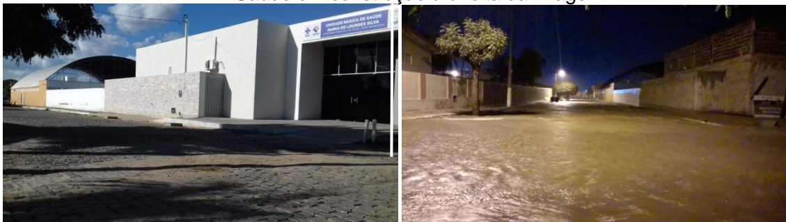
Figura 07 - (a) Unidade Básica de Saúde recém-inaugurada. (b) Unidade Básica de Saúde em construção à direita da imagem.
