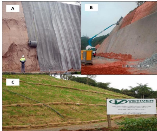
Figura 1 - Proteção de encosta com lona (A), concreto (B) e gramínea (C).
