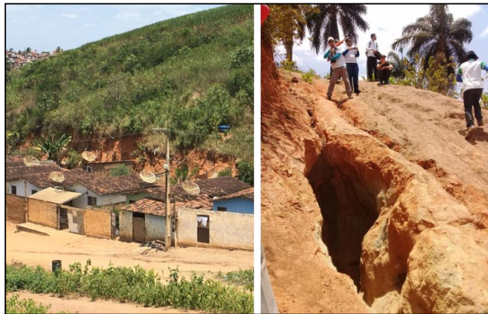
Figura 2 - Encosta com características preocupantes.
