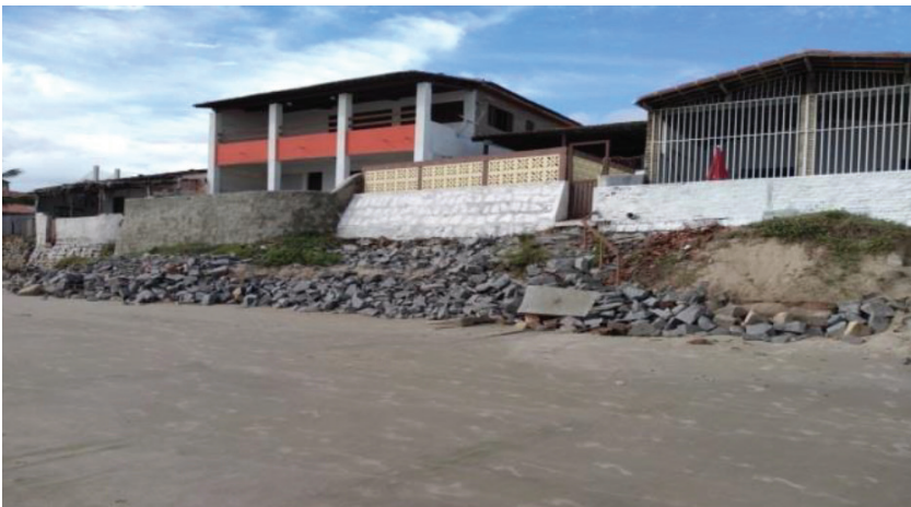
Figura 4 - Erosão e degradação da infraestrutura das habitações residenciais da Praia da Redinha/RN
