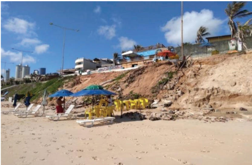
Figura 1 - Processo erosivo e degradação da infraestrutura da orla marítima da praia de Ponta Negra/RN
