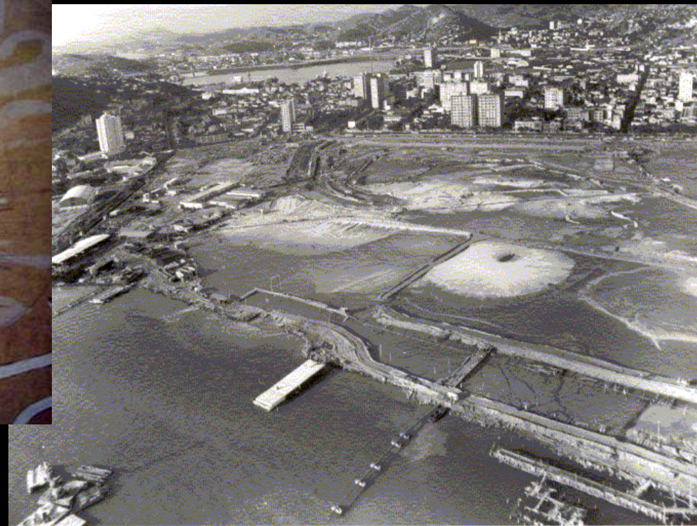
CONTRUÇÃO DO ATERRADO NORTE - 1974
