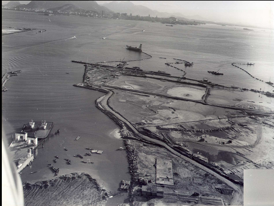
CONTRUÇÃO DO ATERRADO NORTE - 1974
